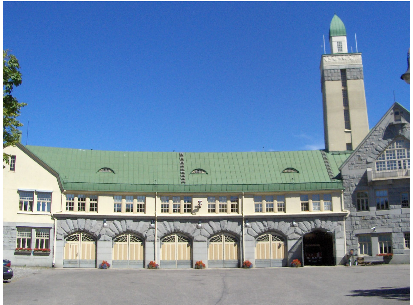
Tammerfors brandstation | 1908, Tammerfors Arkitekt: Wivi Lönn
